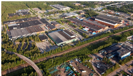
Finnslätten, Västerås' largest industrial park
